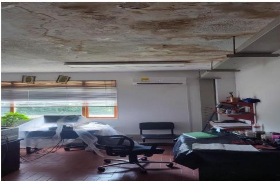
Dirección del establecimiento de reclusión de La Dorada. Los equipos deben taparse inmediatamente se levanta el funcionario debido a que son constantes las caídas de líquido sobre estos.
